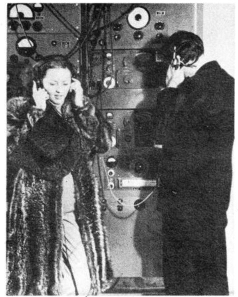
Bild 8. Abstimmung eines Rundfunksenders an der umfangreichen Überwachungsapparatur
